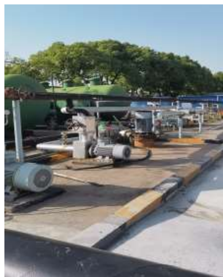
生产废水提升泵站口
