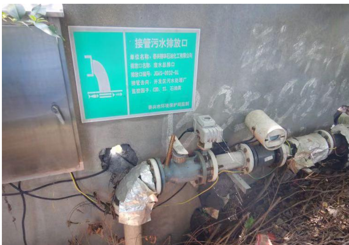
图 2.6-7 接管污水排放口
