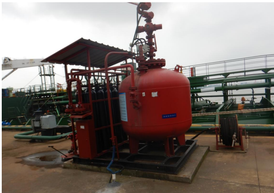
图 2.5-3 泡沫干粉发生装置炮
