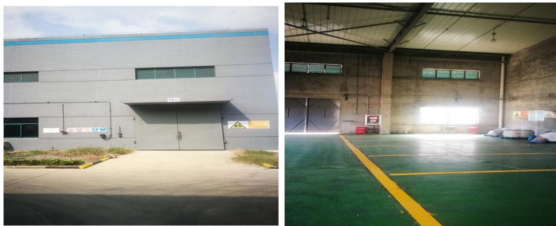
图4.1-5 危废仓库现场照片
